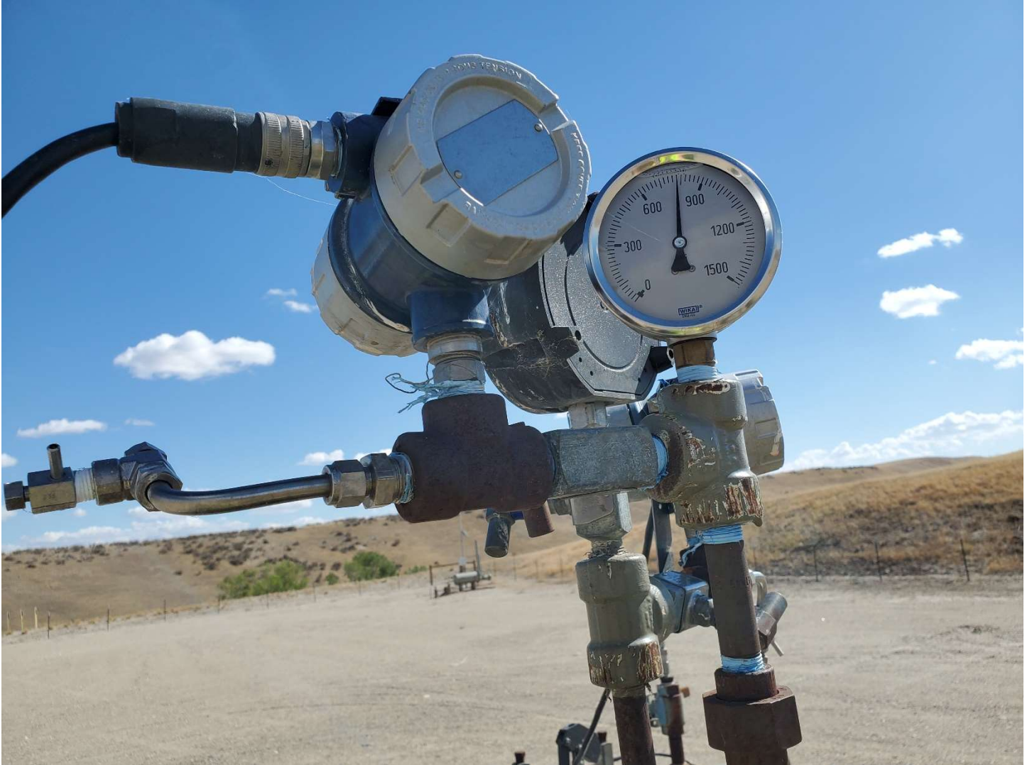
UT tubing gauges.
